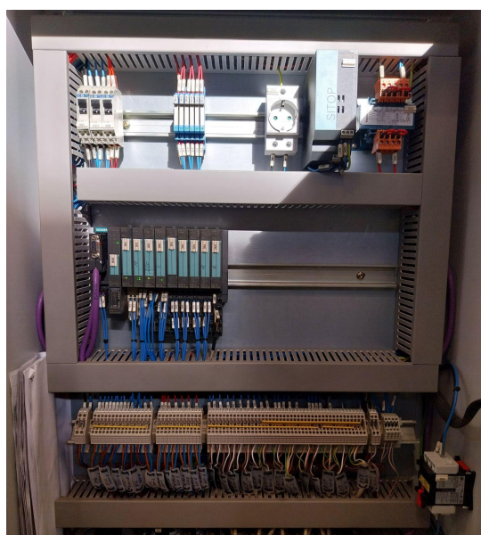
Figura 12. Cuadro bastidores osmosis con HMI
