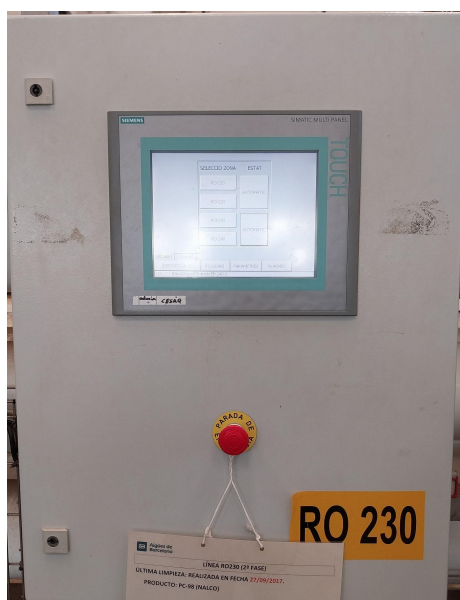
Figura 12. Cuadro bastidores osmosis con HMI
