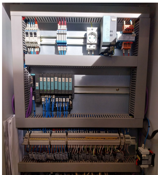
Figura 12. Cuadro bastidores osmosis con HMI
