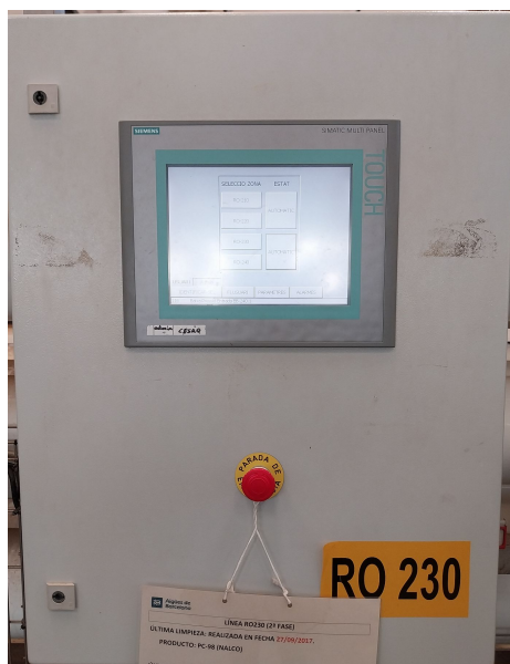
Figura 12. Cuadro bastidores osmosis con HMI
