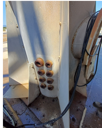
Detalle prensaestopa
