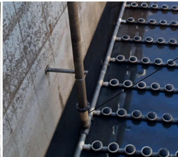
Foto 4:colector unión bajante con distribución parrillas
