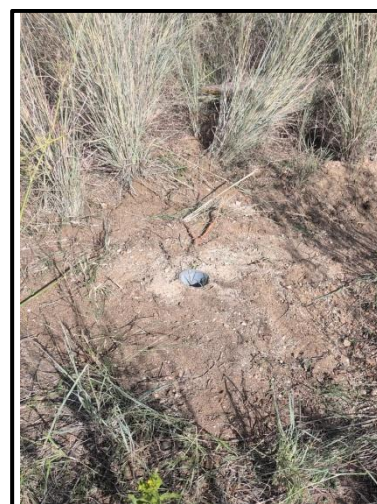
Imatges de les cales manuals obertes per a la comprovació dels possibles serveis soterrats a l'emplaçament dels sondeigs S-1 i S-2 (esquerra i centre) i de la posterior instal·lació d'un tub guia en el sondeig S-3 (dreta).
