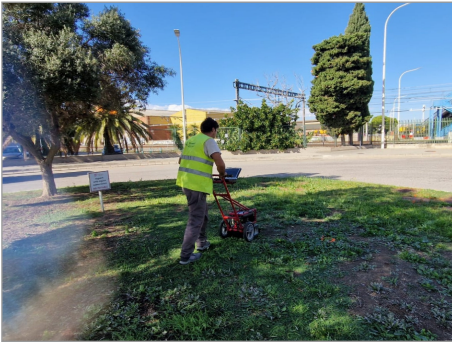
Fotografia 4. Prospecció amb georadar a la Zona2 - Creuament FGC.
