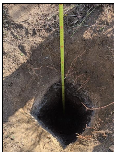
Imatges de les cales manuals obertes per a la comprovació dels possibles serveis soterrats a l'emplaçament dels sondeigs S-1 i S-2 (esquerra i centre) i de la posterior instal·lació d'un tub guia en el sondeig S-3 (dreta).
