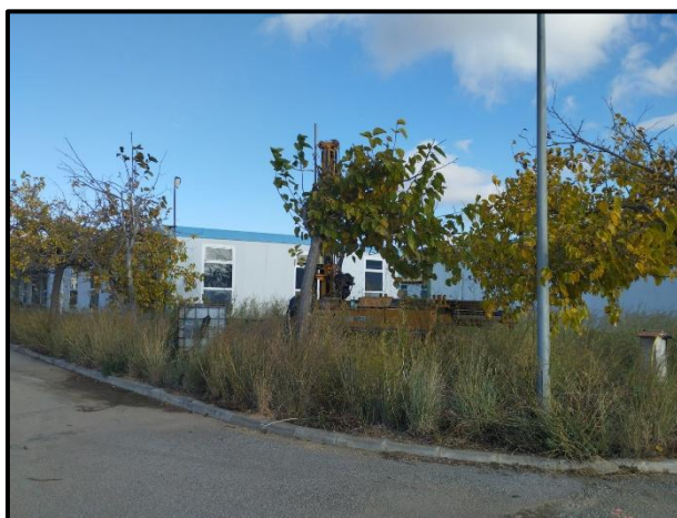
Vista de la parcel·la d'estudi amb la màquina de sondeigs emplaçada en el punt S-3.
