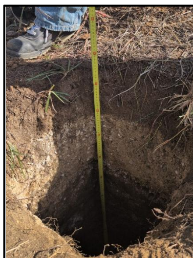
Imatges de les cales manuals obertes per a la comprovació dels possibles serveis soterrats a l'emplaçament dels sondeigs S-1 i S-2 (esquerra i centre) i de la posterior instal·lació d'un tub guia en el sondeig S-3 (dreta).
