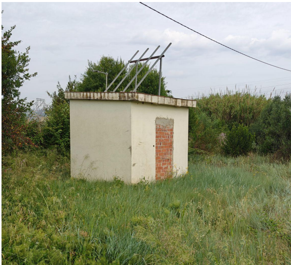
Caseta de control tapiada
