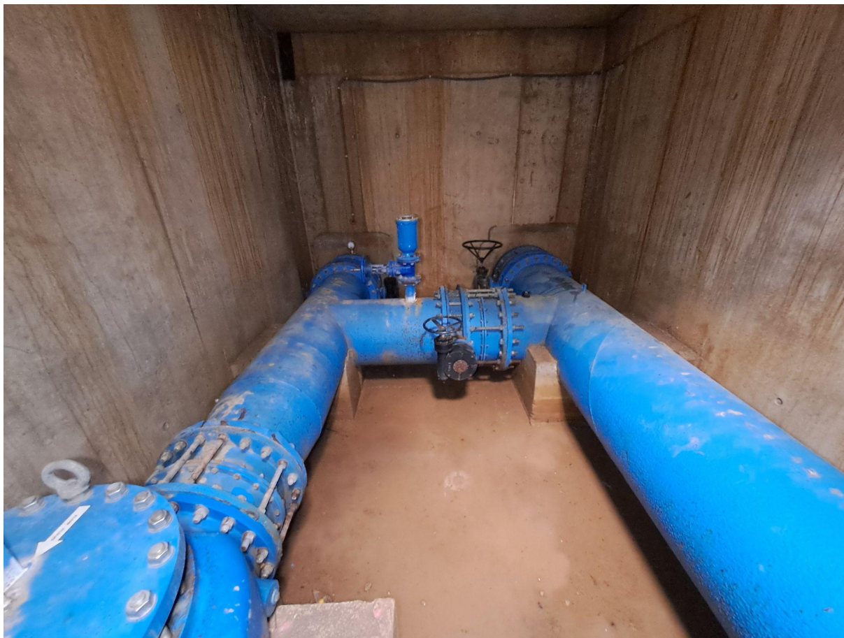
Foto interior arqueta. Dreta entrada a bassa. Esquerra sortida bassa.
