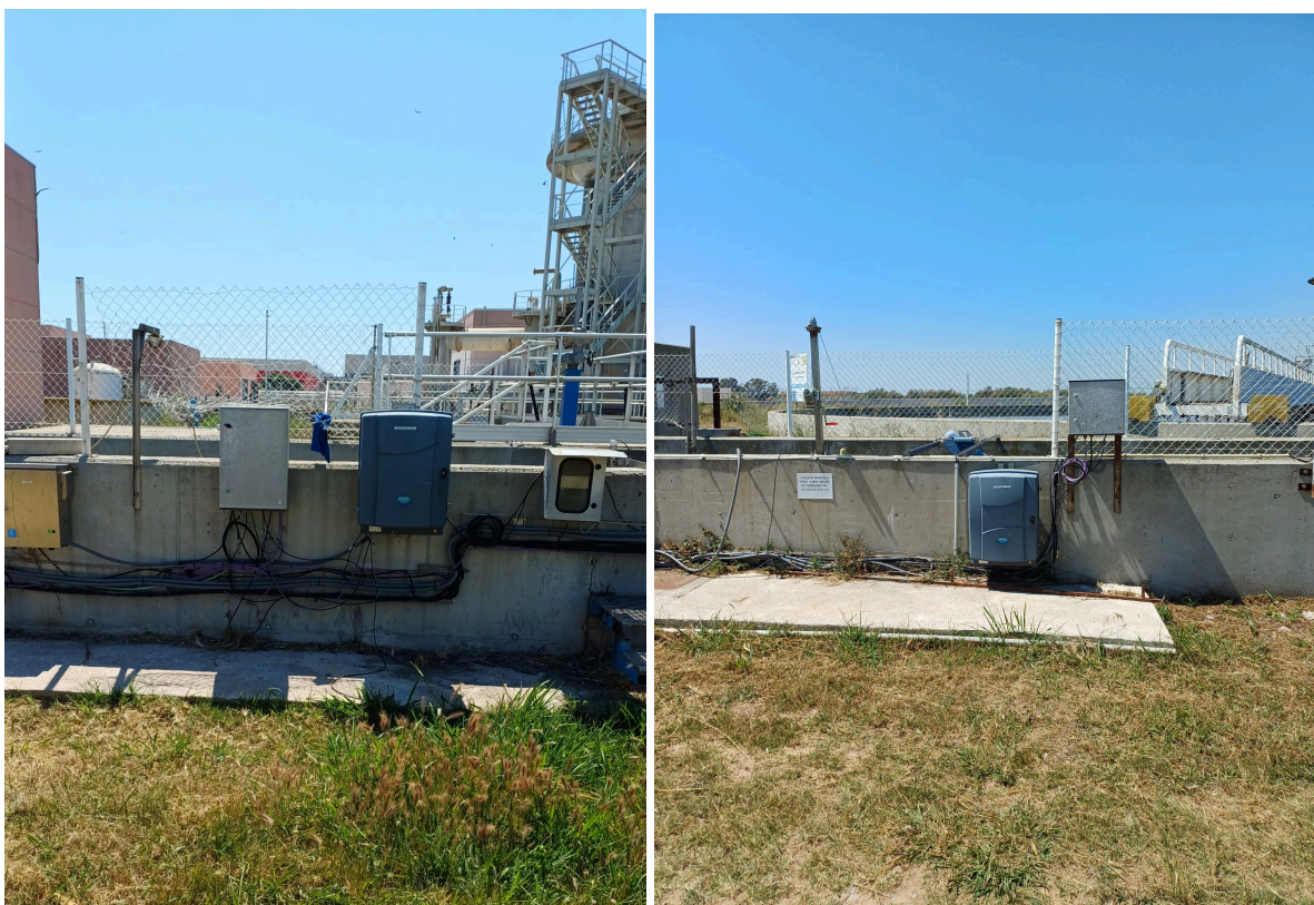
Figura 1. Zona d'instrumentació existent on s'instal·laran els analitzadors de P a canal Barcelona (esquerra) i Prat (dreta)
