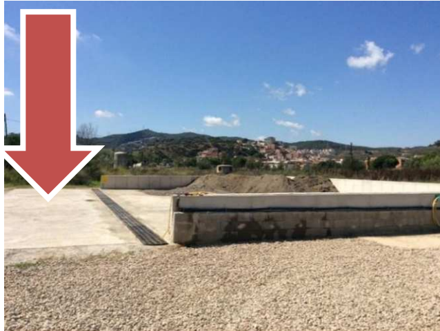
Foto 5: Espacio para la carga de los camiones bañera
