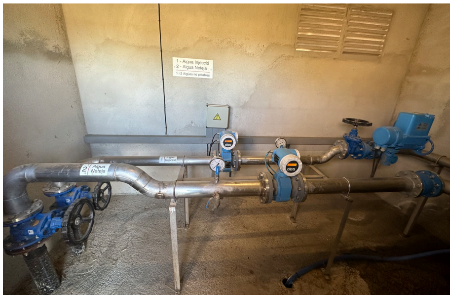
Figura 3. Proceso de inyección y limpieza (Ejemplo Pozo 15)
