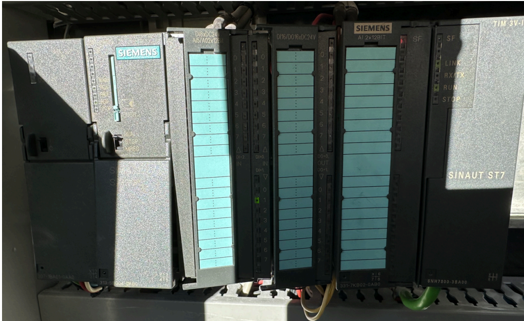
Figura 30. Pozo 11 - CPU 313C y TIM3V-IE
