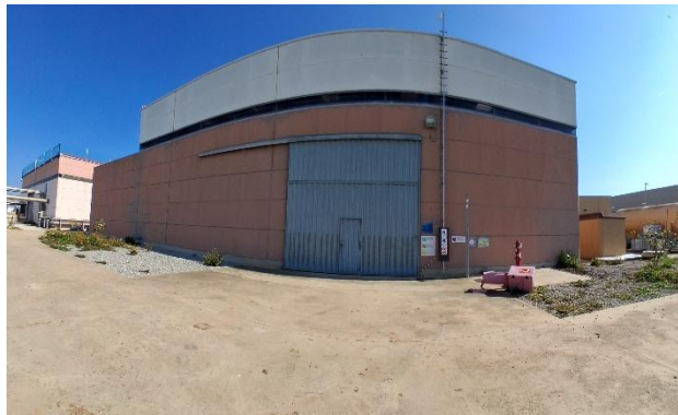
Foto 1: Edifici Bombament reutilització
