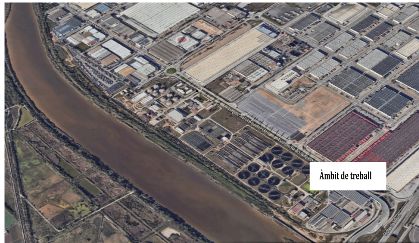
Foto 1: situació EDAR Baix Llobregat
