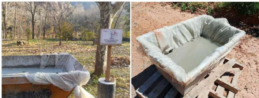
Figura 25. Exemples de punts de neteja de formigoneres habilitats tipus mòbils.
