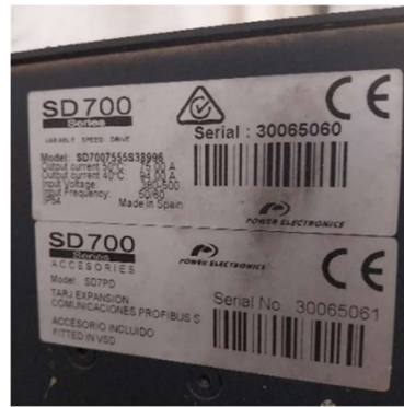
Ilustración 5. Modelo del variador instalado
