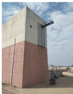
Ilustración 18. Viga carril
