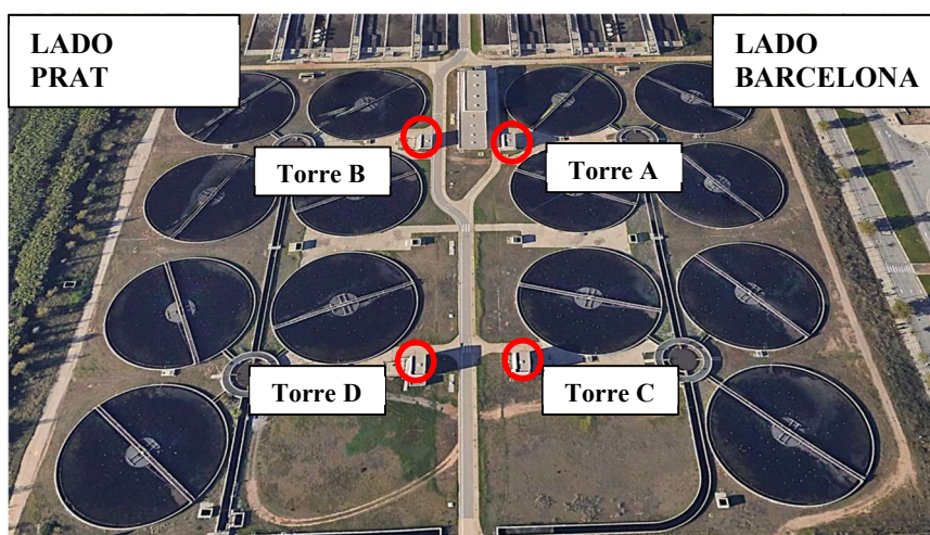
Ilustración 6. Vista aérea de los 14 decantadores y localización de las 4 torres de recirculación
