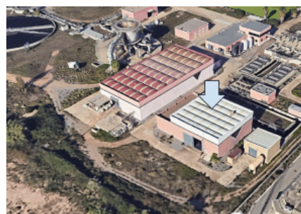
Figura 2. Edificio de bombeo.
