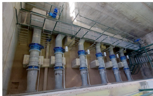
Figura 16. Vista de las tuberías actuales conectadas al colector DN1600.
