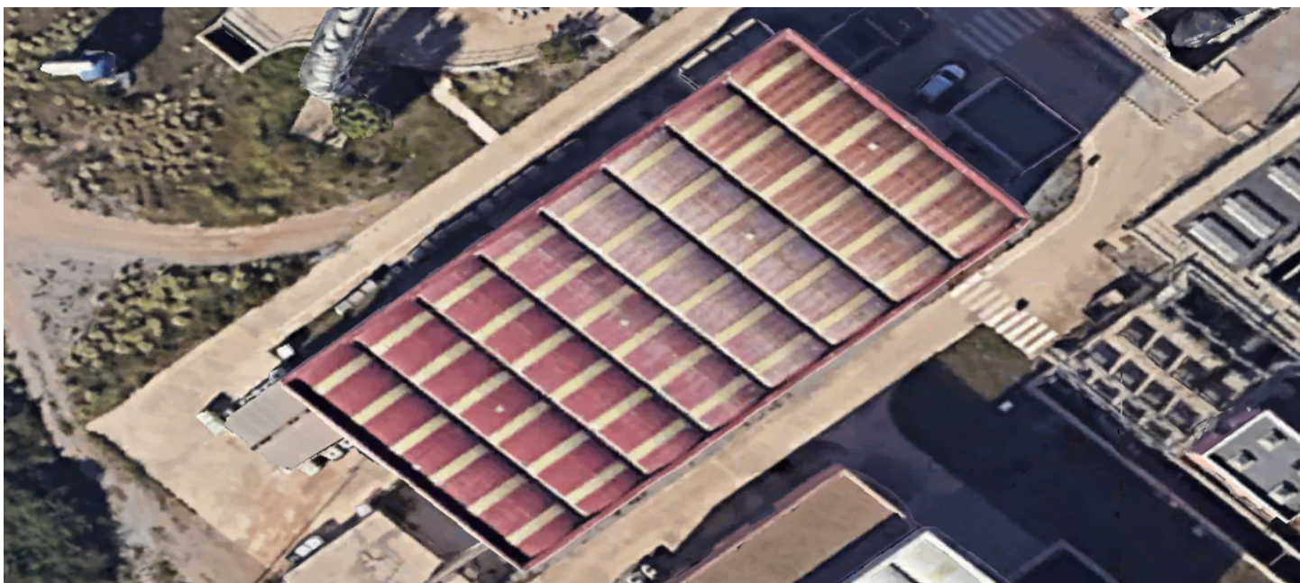
Foto 4: coberta edifici ultrafiltració i osmosi inversa
