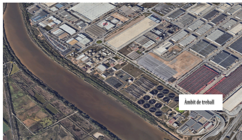
Foto 1: situació EDAR Baix Llobregat
