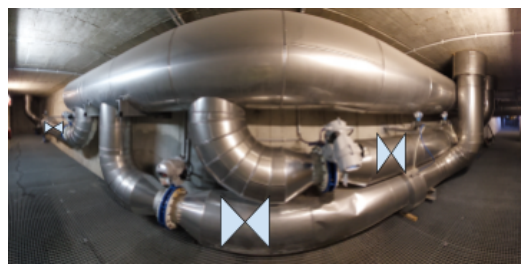
Figura 8. Detalle esquina distribución RB4,5 y 6 (nuevos).
