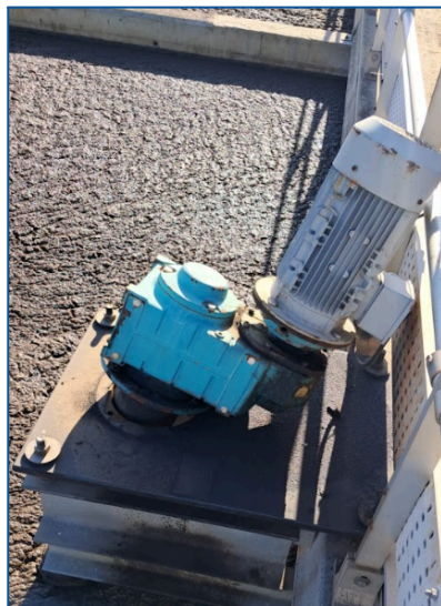
Figura 1. Conjunto motorreductor de algunos de los agitadores de los reactores biológicos a día de hoy
