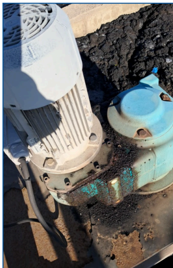
Figura 1. Conjunto motorreductor de algunos de los agitadores de los reactores biológicos a día de hoy
