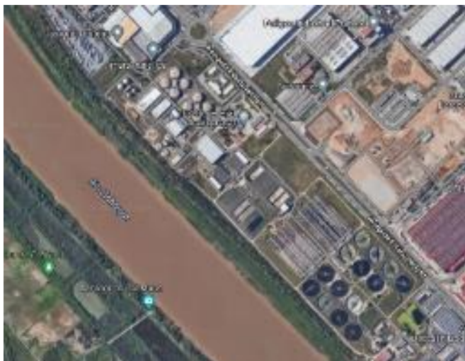
Figura 1 . Vista aérea de la EDAR.
