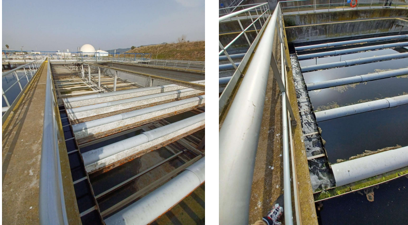
Vista general dels sobreixidors transversals i canals de recollida longitudinal
