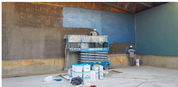
Plataforma semblant a la necessària per la realització dels treballs
