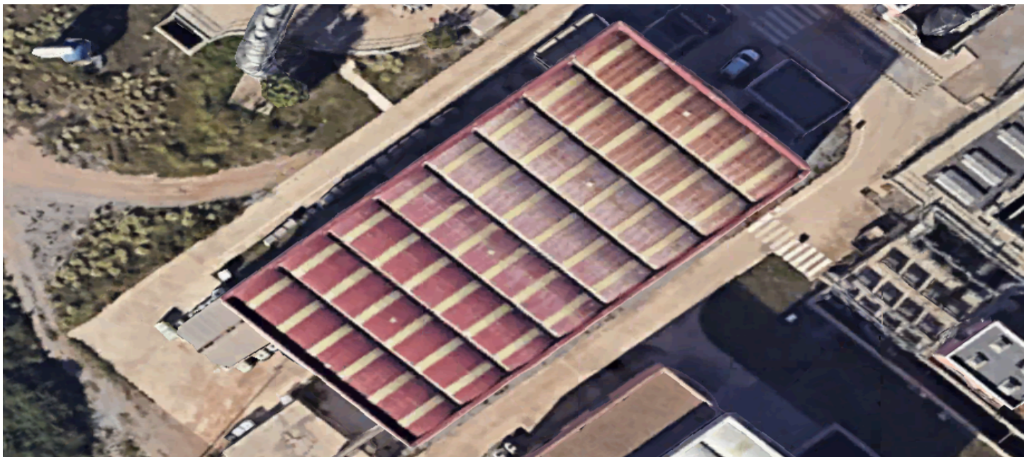
Foto 4: coberta edifici ultrafiltració i osmosi inversa
