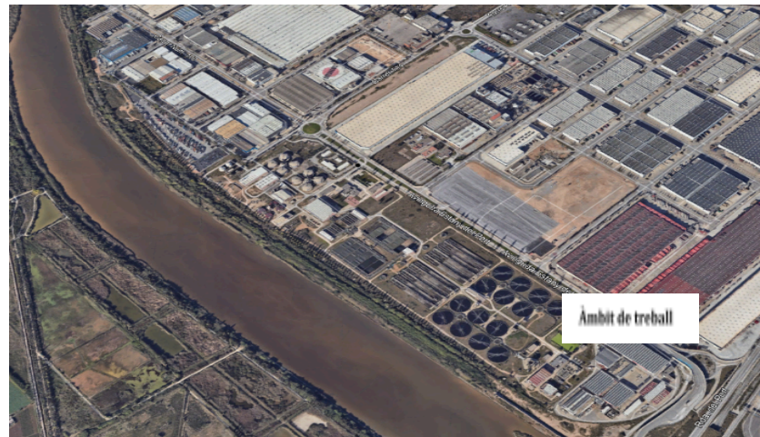
Foto 1: situació EDAR Baix Llobregat
