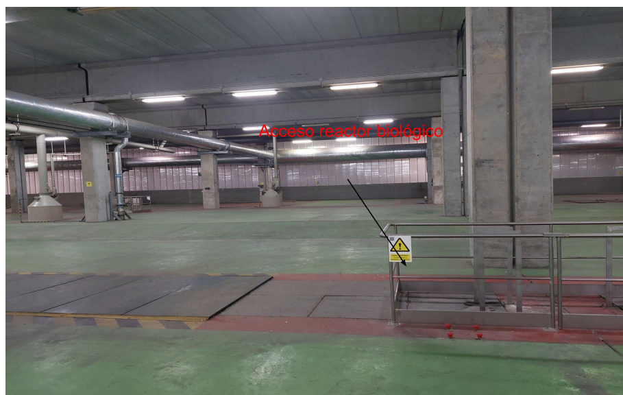
Foto 2: zona superficial Reactor Biológico
