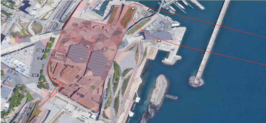
Foto 1: situación del EDAR del Besós
