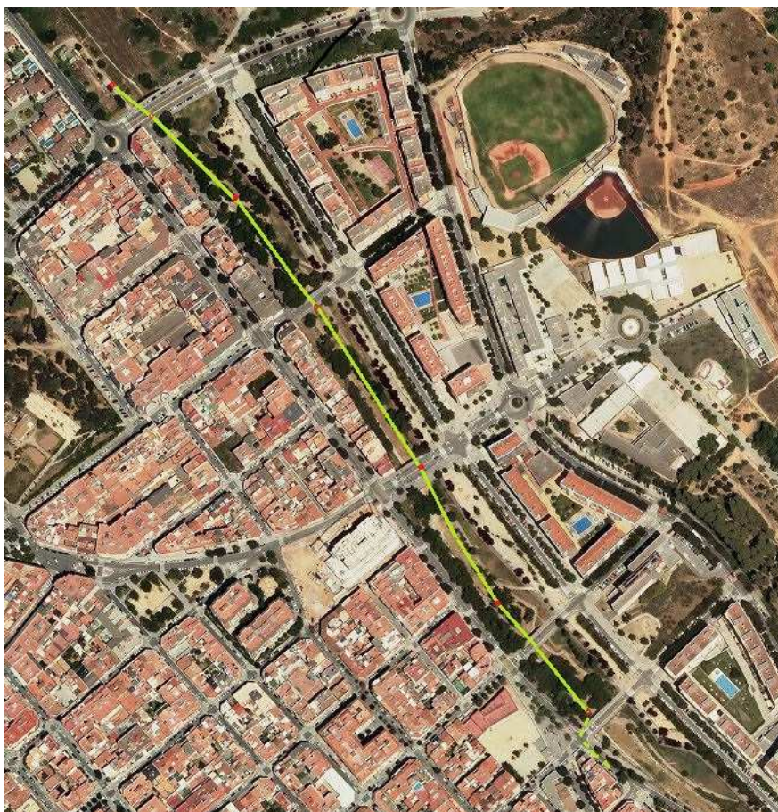
Traçat del tram de col·lector de la riera de Sant Climent a Viladecans , entre els pous PR56 i PR-40
